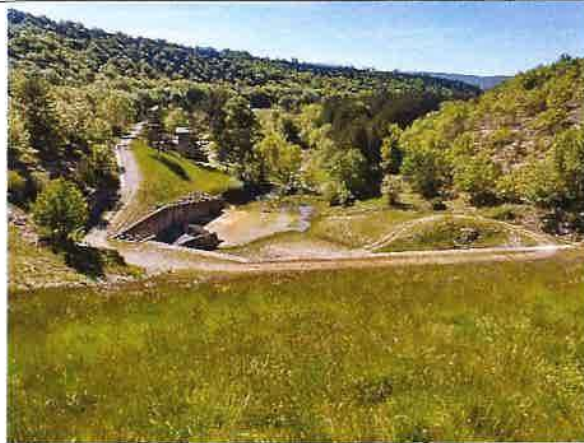
1 - Vue de l'aval du Barrage depuis la crête
