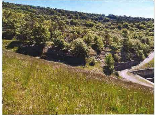
2 - Vue sur la RD13 en rive gauche à l'aval du barrage
