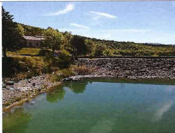
7 - Vue sur la berge en rive gauche, lieu d'installation du futur évacuateur latéral depuis la tour de prise d'eau actuelle
