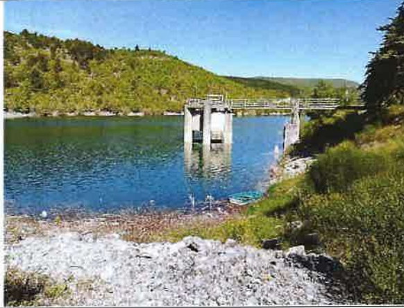
5 -Vue sur l'évacuateur de crue actuel
