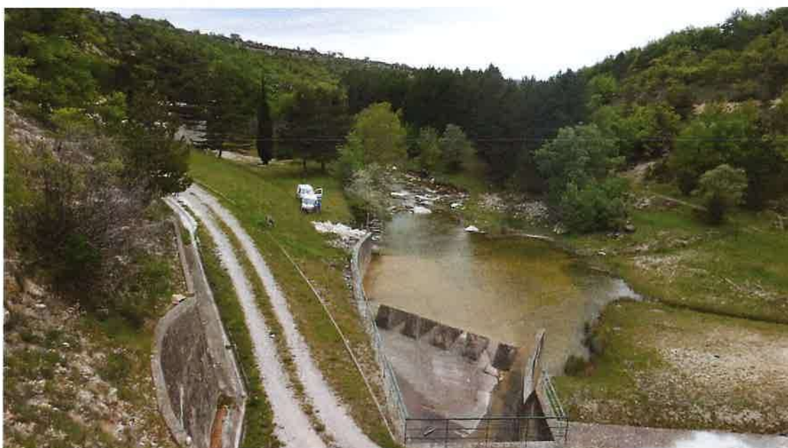
La Laye en aval du barrage et un cordon rivulaire très peu marqué
