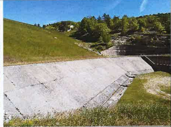
6 Vue sur la digue du barrage depuis la rive droite aval
